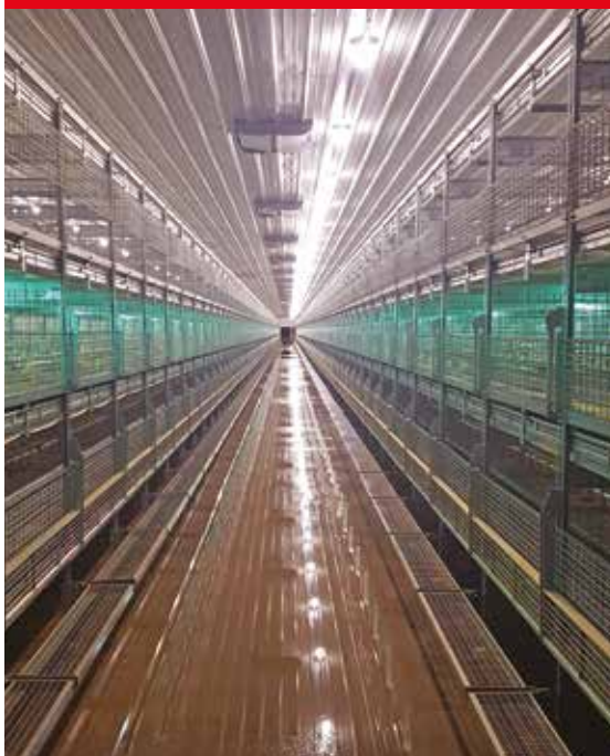
Avant logement des oiseaux
